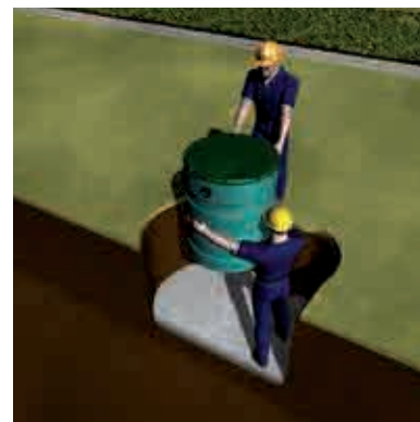
3a. POSIZIONAMENTO DELLA VASCA
