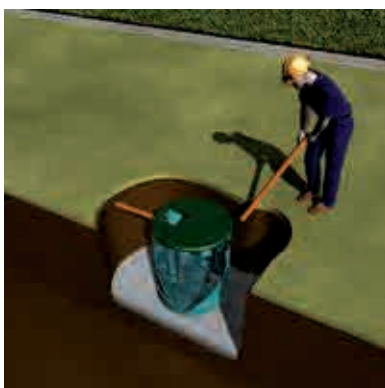
4a. COLLEGAMENTO DELLE TUBAZIONI
