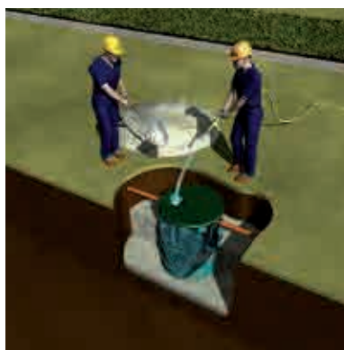
5a. RINFIANCO DELLO SCAVO
